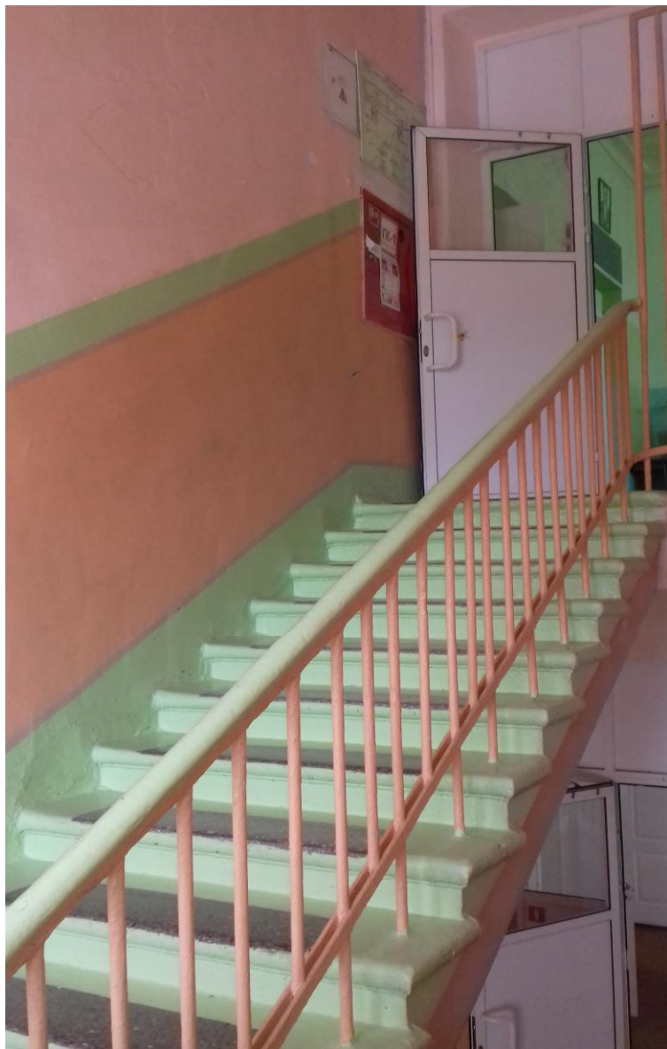
Фото 9. Лестница (внутри здания)
