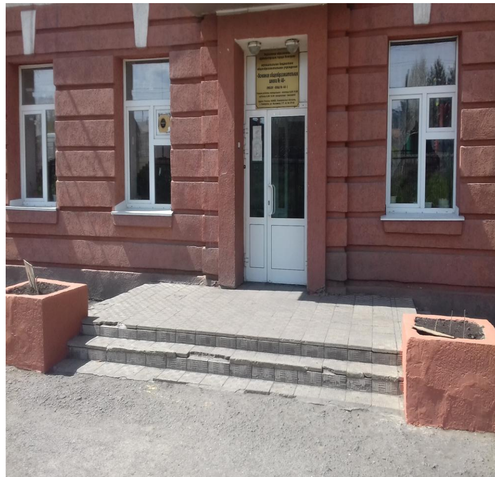
Фото 6. Лестница (наружная) и входная площадка перед дверью
