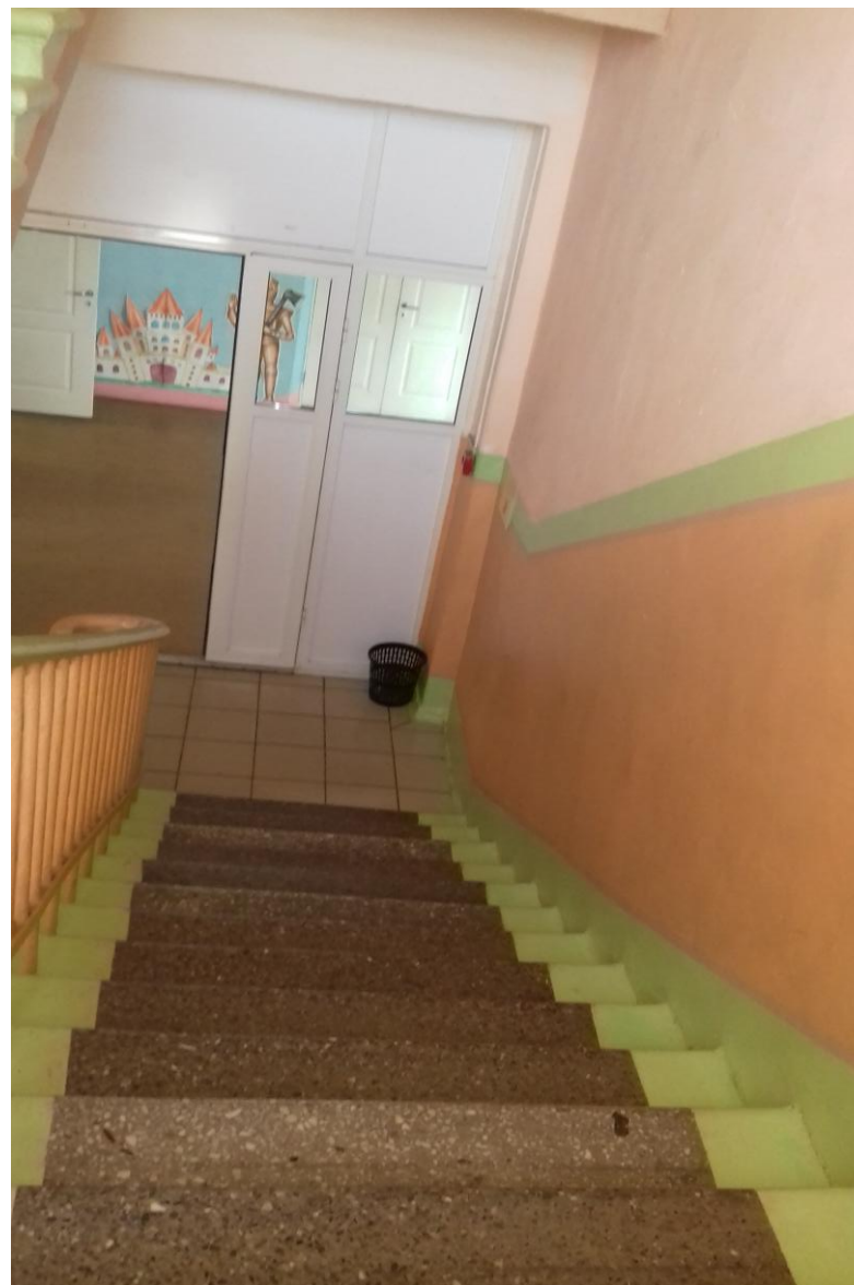
Фото 10. Лестница (внутри здания)
